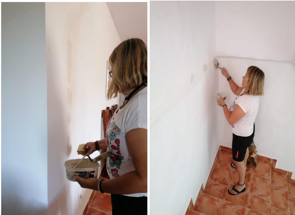
En el Ojal tapando las grietas
